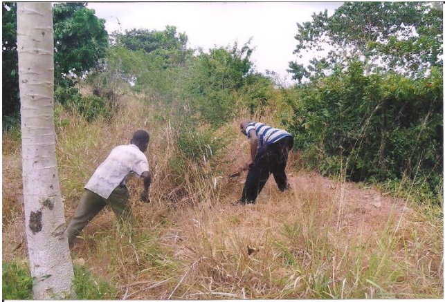
Operai al lavoro per ripulire il terreno dove dovrebbe sorgere la scuola materna.
